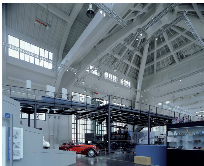
Bild 2: Hallenheizung der Münchner Museumshallen
